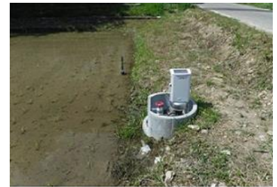
用水路のパイプライン化
