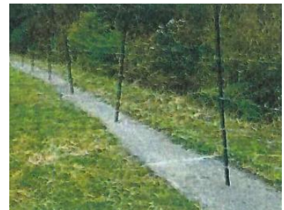
鉄鋼スラグ材の敷設例
