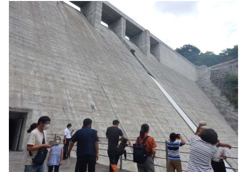
【利用促進事業の様子 (金出地ダム見学ツアー)】
