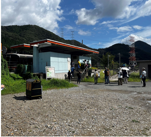
【千本駅駐車場整備（予定）】
