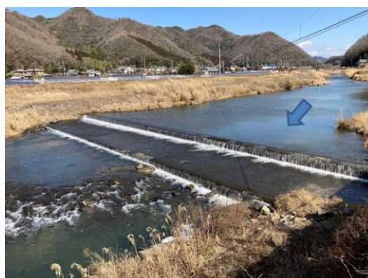
落差工の段差解消
