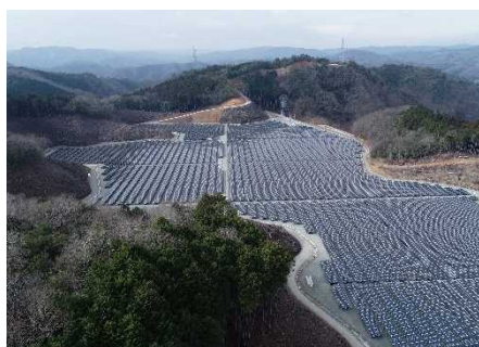
災害復興事業で発生した残土処分地を活用し設置された「佐用・IDEC 秀谷太陽光発電所」(佐用町)
