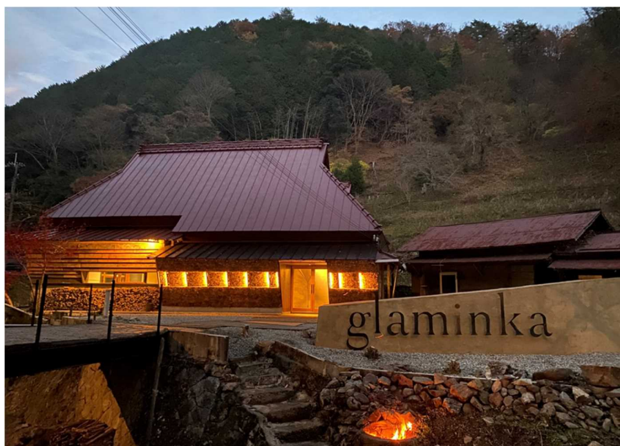
住民が1世帯となった若州集落の空き家6棟を再生した1棟貸しの宿泊施設「グラミンカ SAYO」(佐用町)
