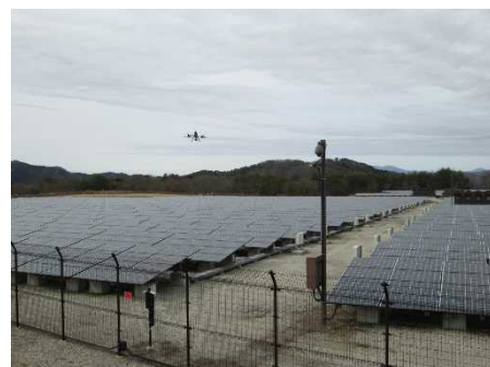
播磨科学公園都市内の太陽光パネルを点検するドローン
