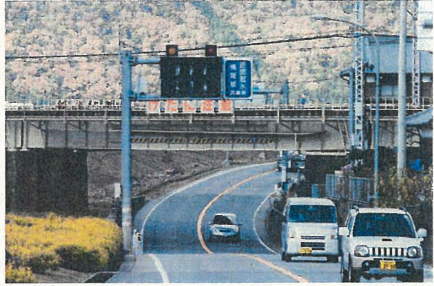
冠水情報板(国道373号興井JRアンダー交差部)
