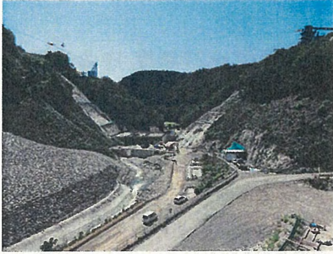
金出地ダム工事中写真(上郡町金出地)
