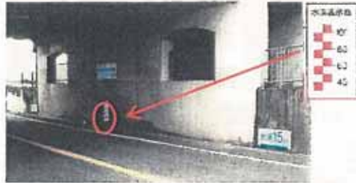
道路アンダーパスの水深表示板
