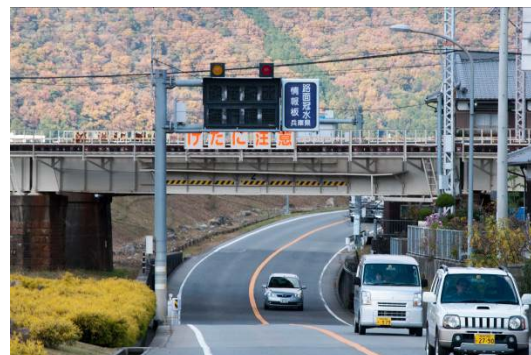
図 6-3.4 冠水情報板 (国道 373 号 興井 JR 交差部)
