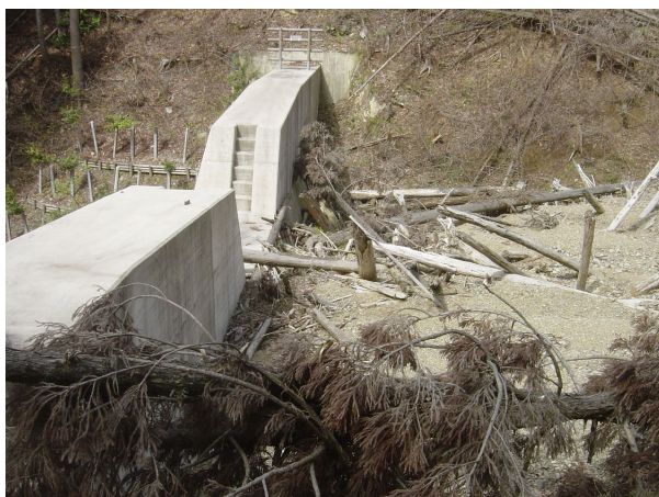
写真 5-7-1 H21 年災害時における治山ダムの効果事例（佐用町水根）
