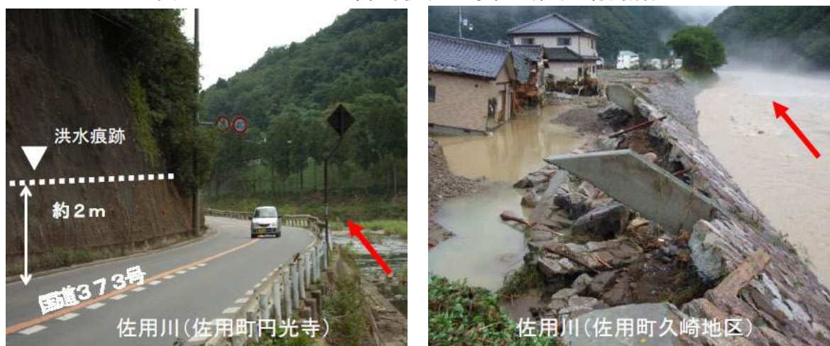
写真 1-2-2 洪水痕跡と被害状況 (佐用川)
