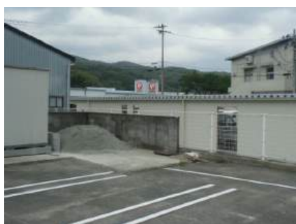
土のう用ダストの設置（佐用町）
