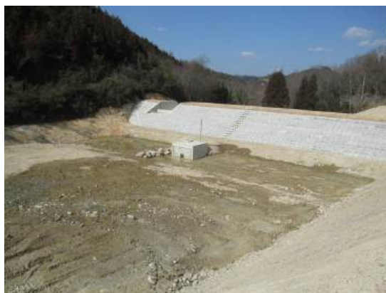
写真 2-2-3 廃止ため池の雨水貯留施設整備（新池（相生市））
