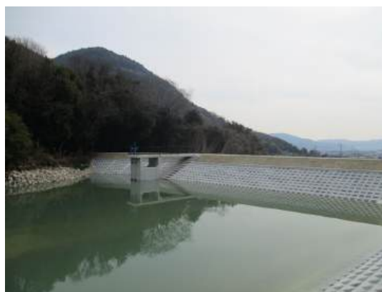
写真 2-2-4 事前放流設備（取水施設改良型）を整備した折方新池（赤穂市）
