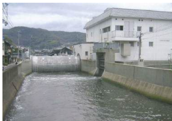
写真 2-1-3 大谷川（排水機場）
