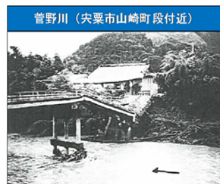
S51.9 被災状況
