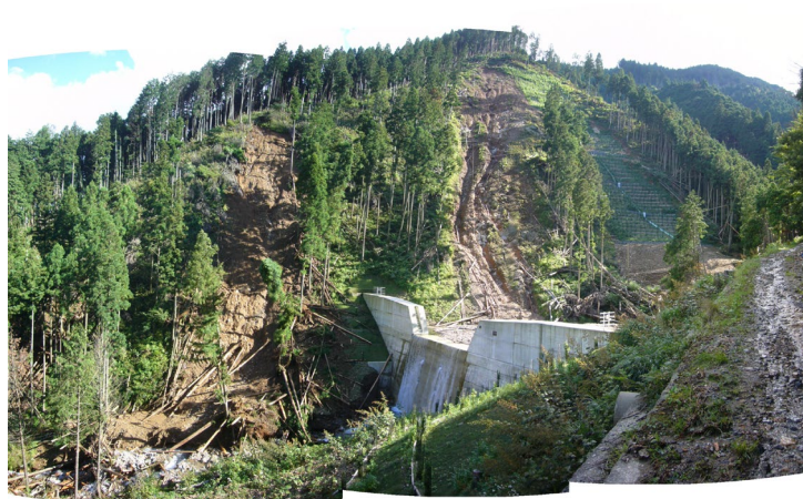
写真 5-6.1 平成 21 年災害時における治山ダムの効果事例（一宮町杉田）
