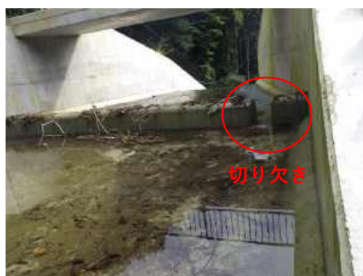
写真 2-2. 3 ため池の排水用切り欠きの設置例
