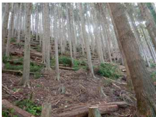
間伐材を利用した土留工 (宍粟市一宮町千町地区)
