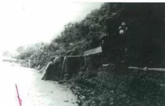
流出した県道 6 号線 (曲里付近)
