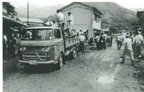
末元川(染河内川支川)の氾濫 (宍粟市一宮町)
