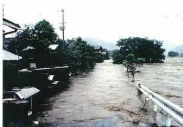
宍粟橋右岸浸水状況(宍粟市山崎町)
