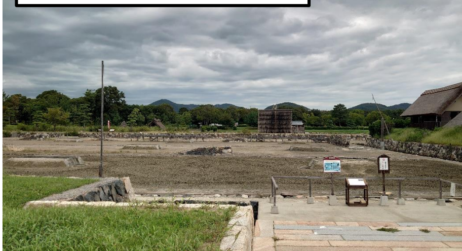
入り浜式塩田改修工事前
