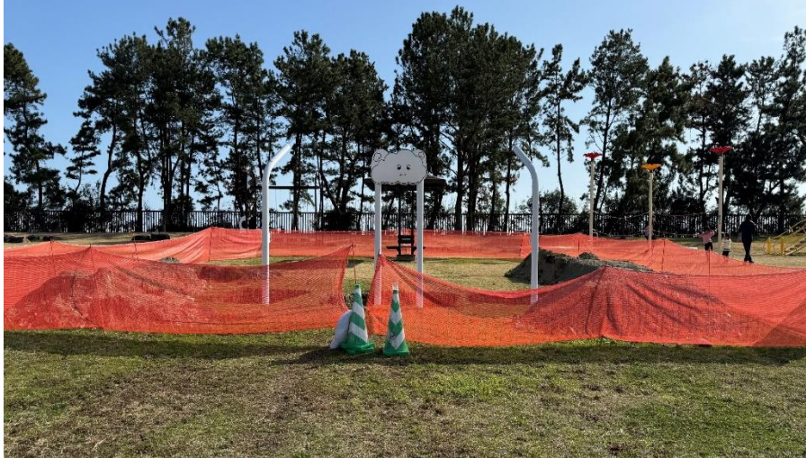
水遊び場 整備工事
