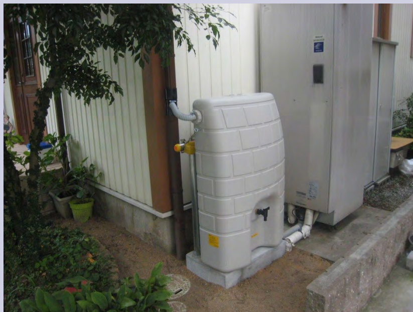
設置された雨水タンク（たつの市）
