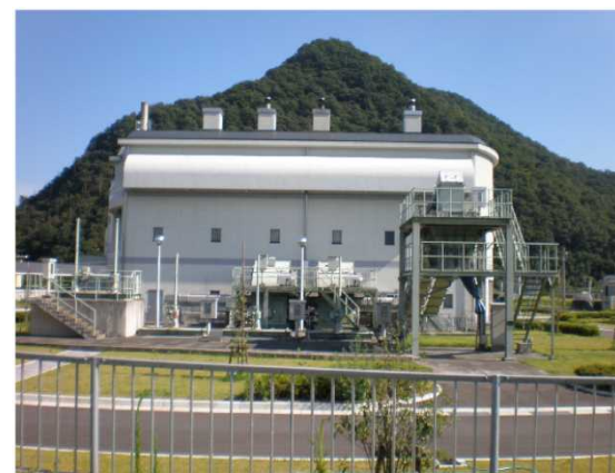
駅前雨水ポンプ場（上郡町）
