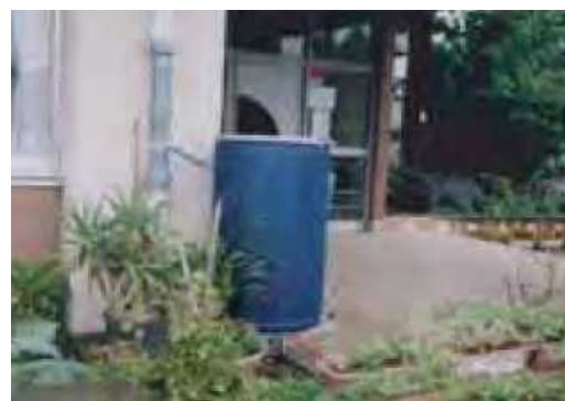
各戸貯留施設の例（地上タイプ）
