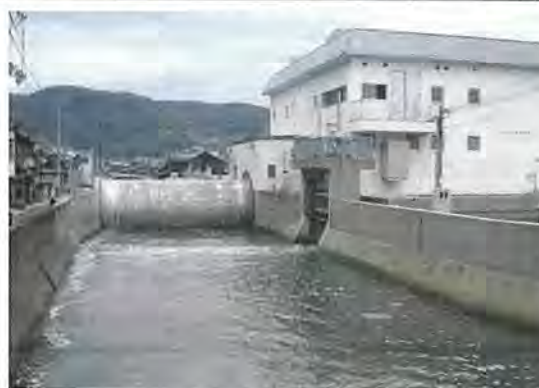
大谷川（排水機場）
