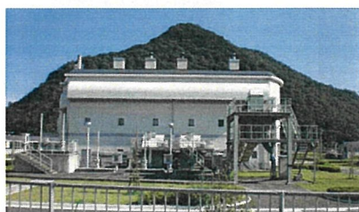
駅前雨水ポンプ場 (上郡町)
