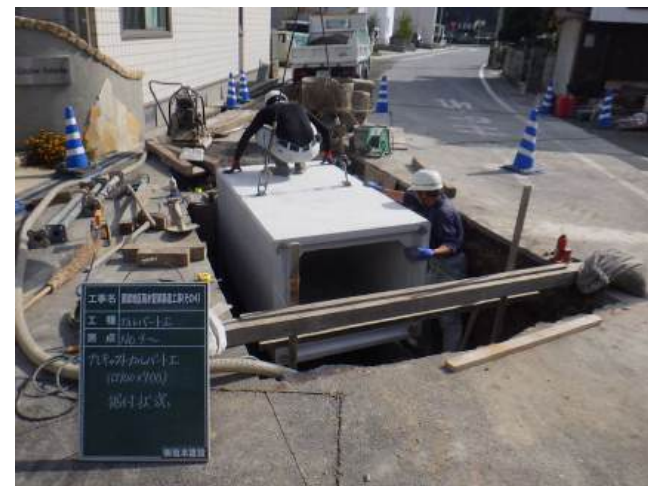
那波地区雨水函渠築造工事 (相生市)
