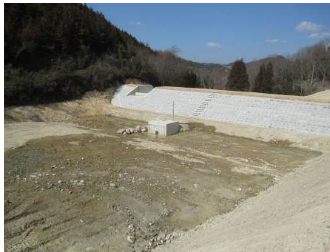
廃止ため池の雨水貯留浸透施設整備（新池）
