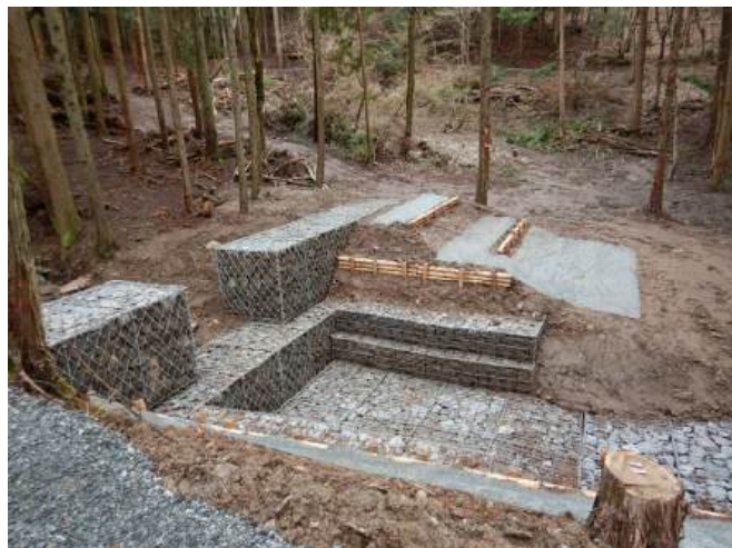
かご枠工設置 (佐用町安川地区)
