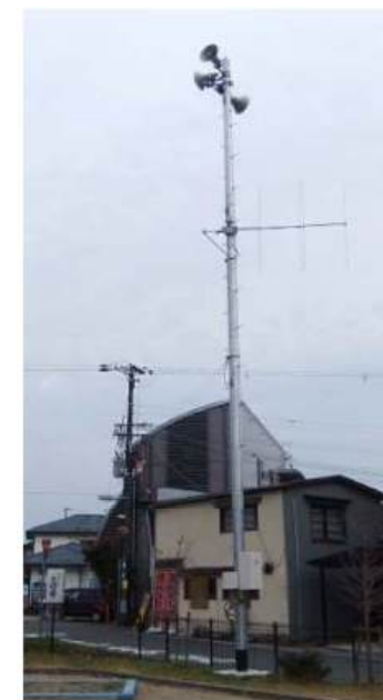
相生市施工子局装置
