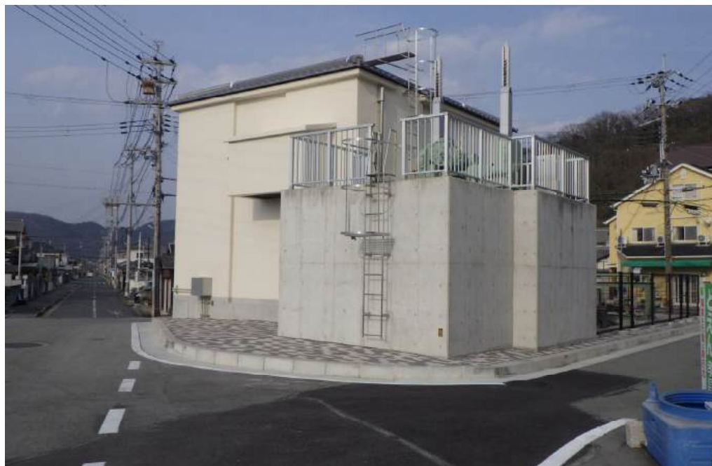
御崎第2ポンプ場 (59m 3 /分) × 2台の整備 (赤穂市)
