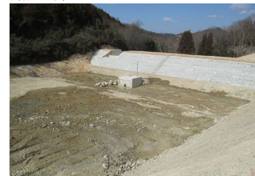
新池(施工状況)
