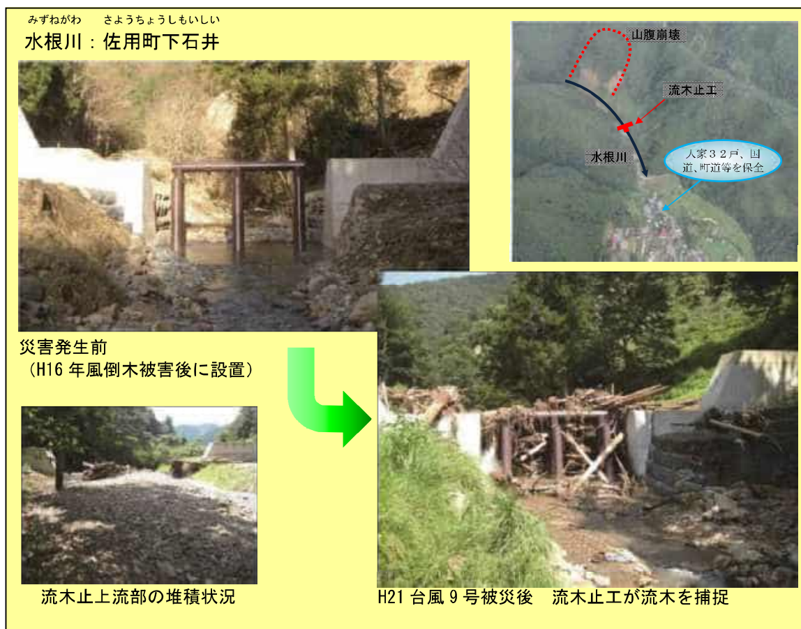
図 5-6 砂防施設の効果事例（佐用町）
