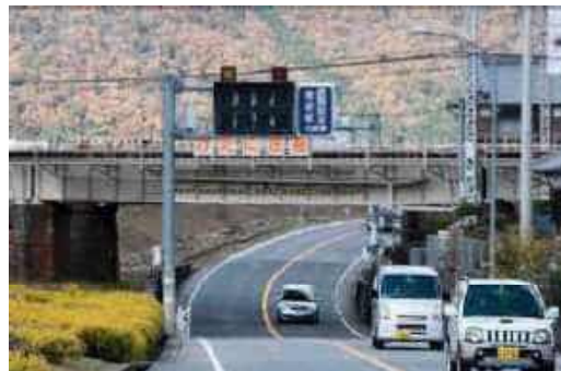
写真 6-3 冠水情報板 (国道 373 号 興井 JR 交差点部)
