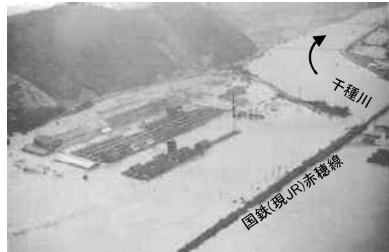
写真 1-6 S51.9 洪水の状況
