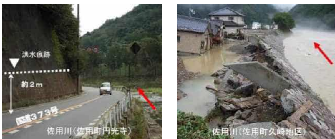
写真 1-8 洪水痕跡と被災状況（佐用川）
