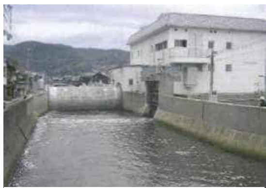
写真 1-11 大谷川（排水機場）
