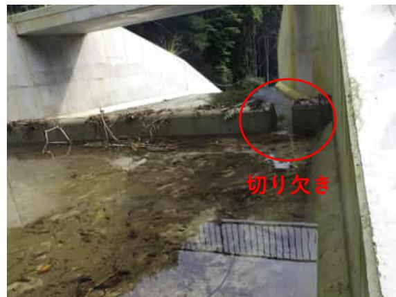
ため池改修に合せた事前放流設備（洪水吐改良型）の整備（宍粟市）
