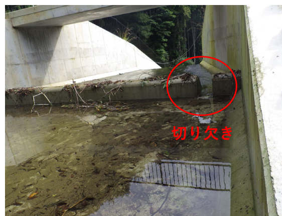
②ため池改修に合せた事前放流設備（洪水吐改良型）の整備（宍粟市）
