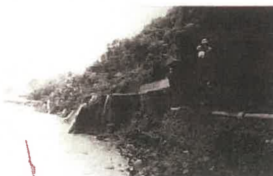
流失した県道 6 号線(曲里付近)
