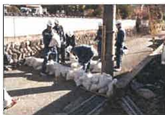
土嚢積み（宍粟市）
