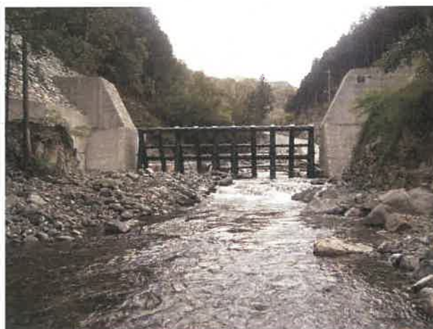
写真 5-6 砂防えん堤(福知川)
