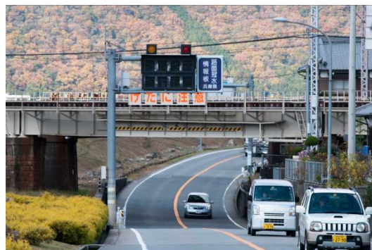
図 6-3.4 冠水情報板 (国道 373 号 興井 JR 交差部)
