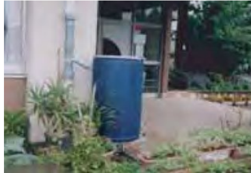
図 5-2.2 各戸貯留施設の例(地上タイプ)
