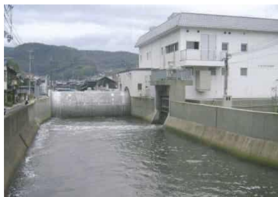
写真 2-1-3 大谷川（排水機場）
