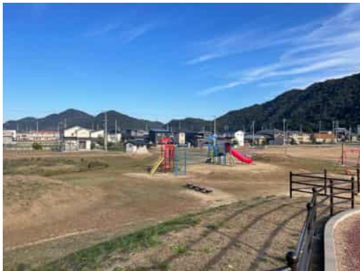
【公園貯留】野中・砂子防災公園（赤穂市）
