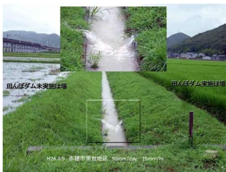
写真 2-2-2 田んぼダムの実施事例（赤穂市周世地区）
