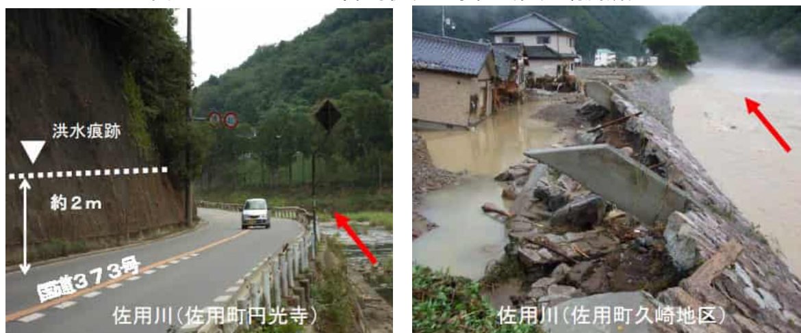
写真 1-2-2 洪水痕跡と被害状況 (佐用川)
