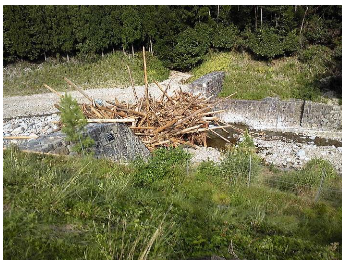
写真 5-6.2 平成 21 年災害時における砂防堰堤の効果事例（谷川砂防堰堤）
