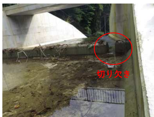
写真 2-2. 3 ため池の排水用切り欠きの設置例
