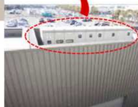
受配電設備・非常用発電設備の高所設置
