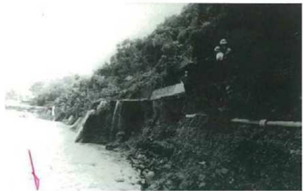
流出した県道 6 号線 (曲里付近)
