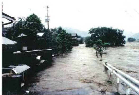
宍粟橋右岸浸水状況(宍粟市山崎町)
