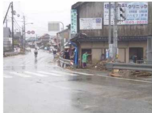
安積橋下流の浸水状況(宍粟市一宮)
