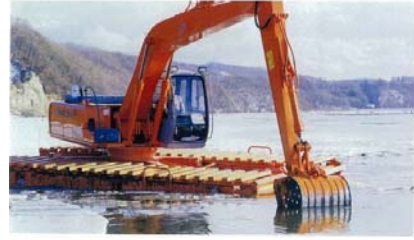
泥上掘削機(覆砂および埋め戻し均し)
