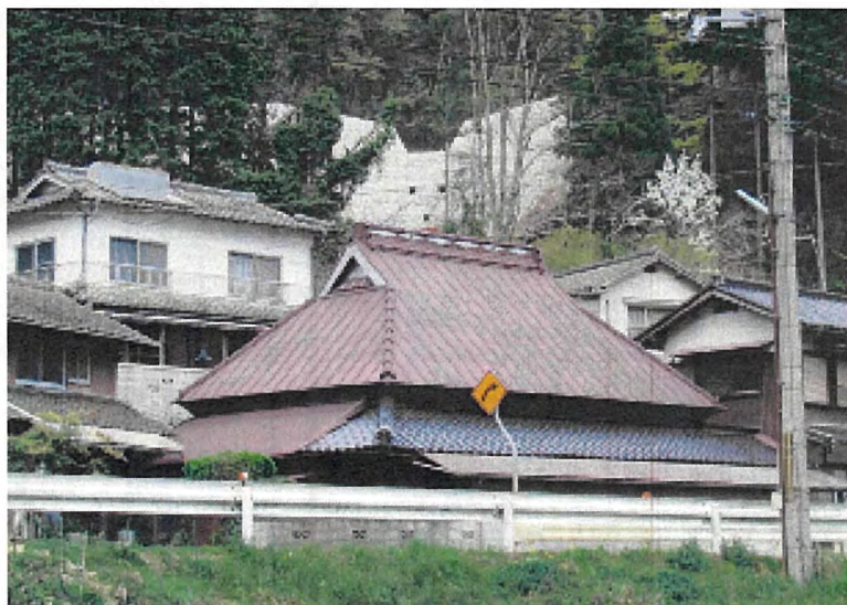
砂防えん堤(佐用町下石井 東谷川)
