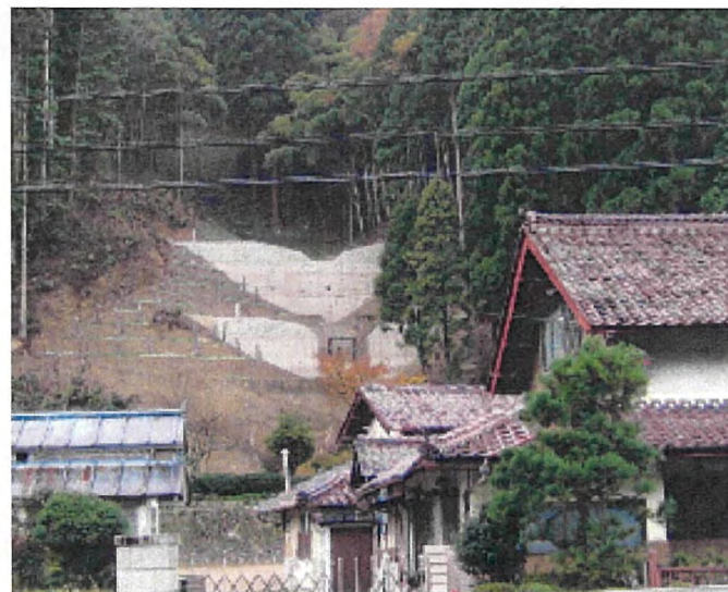
治山ダム(朝来市 八代)
