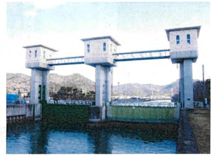
塩屋川防潮水門 (30年経過)
