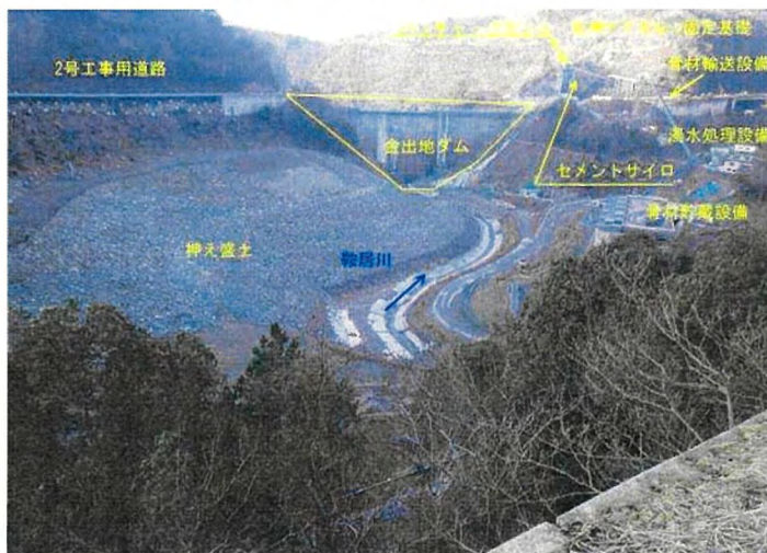
上流から金出地ダムをのぞむ (H27.1)
